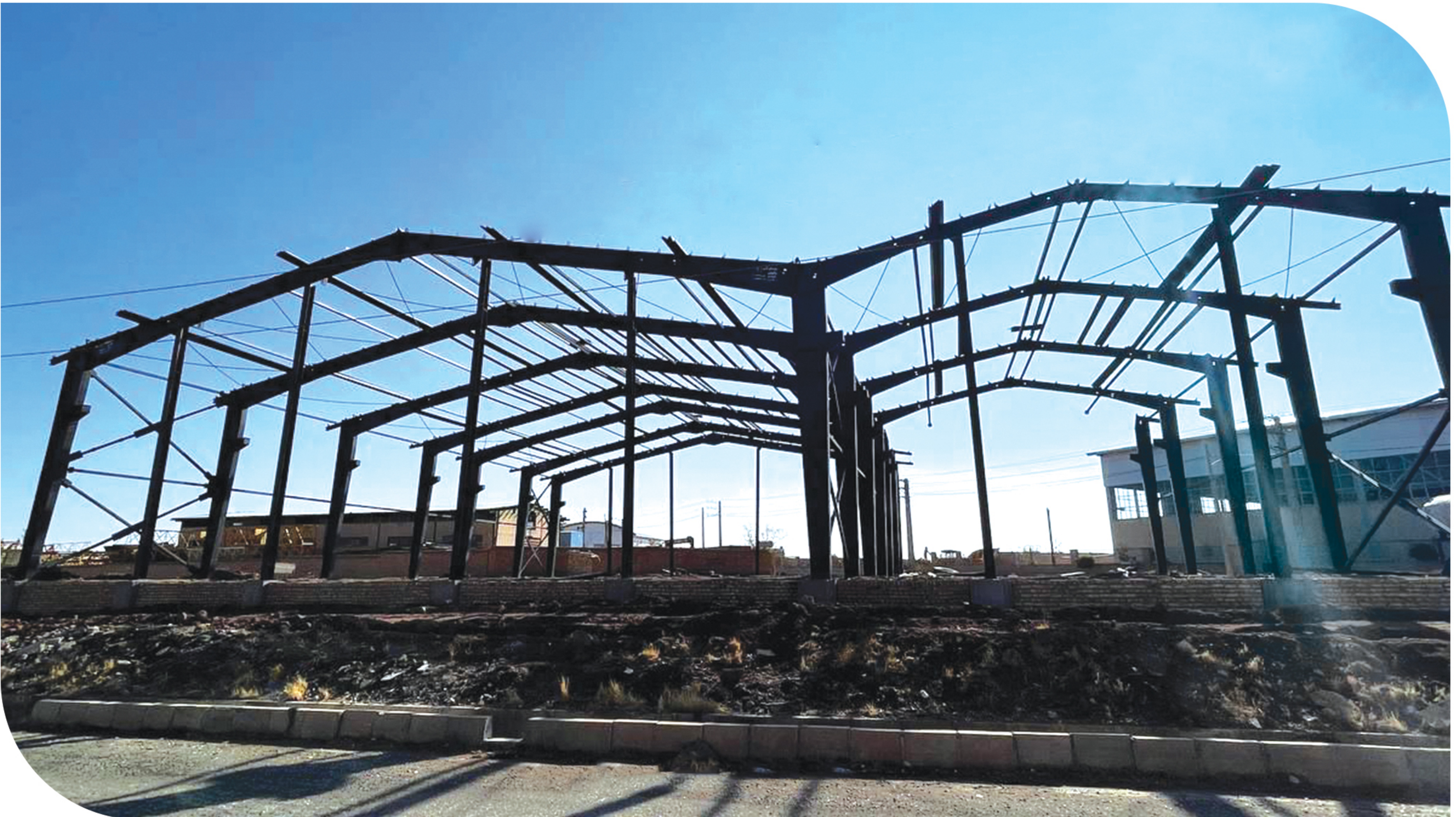
اجرای فونداسیون، ساخت و نصب سوله شرکت صبا فز- شهرک صنعتی پرند
